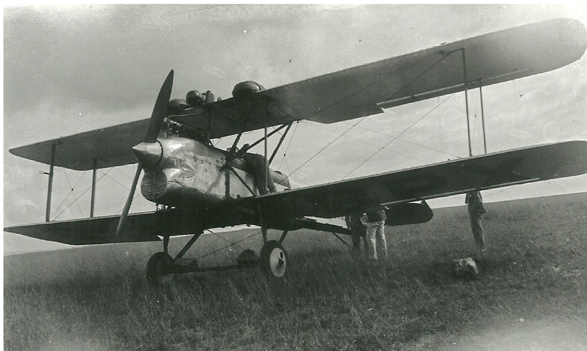
Le Vickers Vendace, avion anglais. Sur l'aile supérieure : 2 réservoirs.
